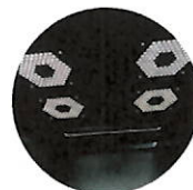
Teto com ventilação e passagem de cabos
